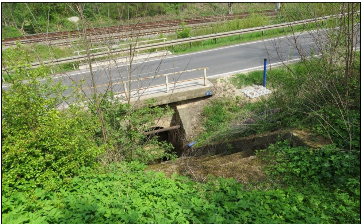
Abb. 7: Faulgraben – Ausgebauter Durchlass unter der L 1061
