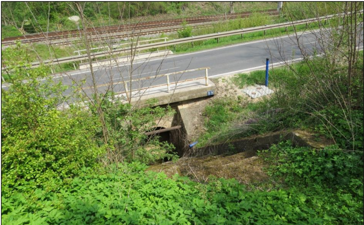
Abb. 7: Faulgraben – Ausgebauter Durchlass unter der L 1061
