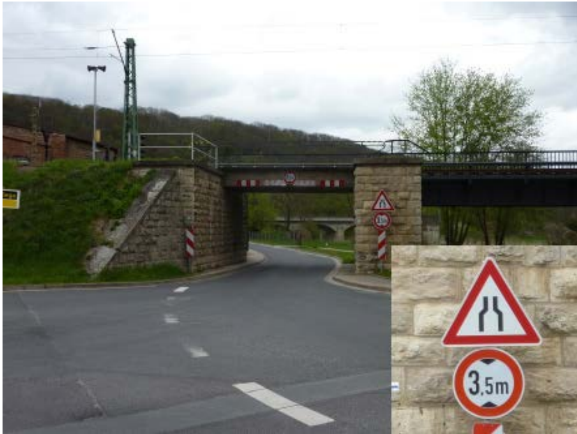
Brückenbauwerk Bahn-Strecke Großheringen – Jena Straßenknoten L 1061 Abzweig Viegastraße
