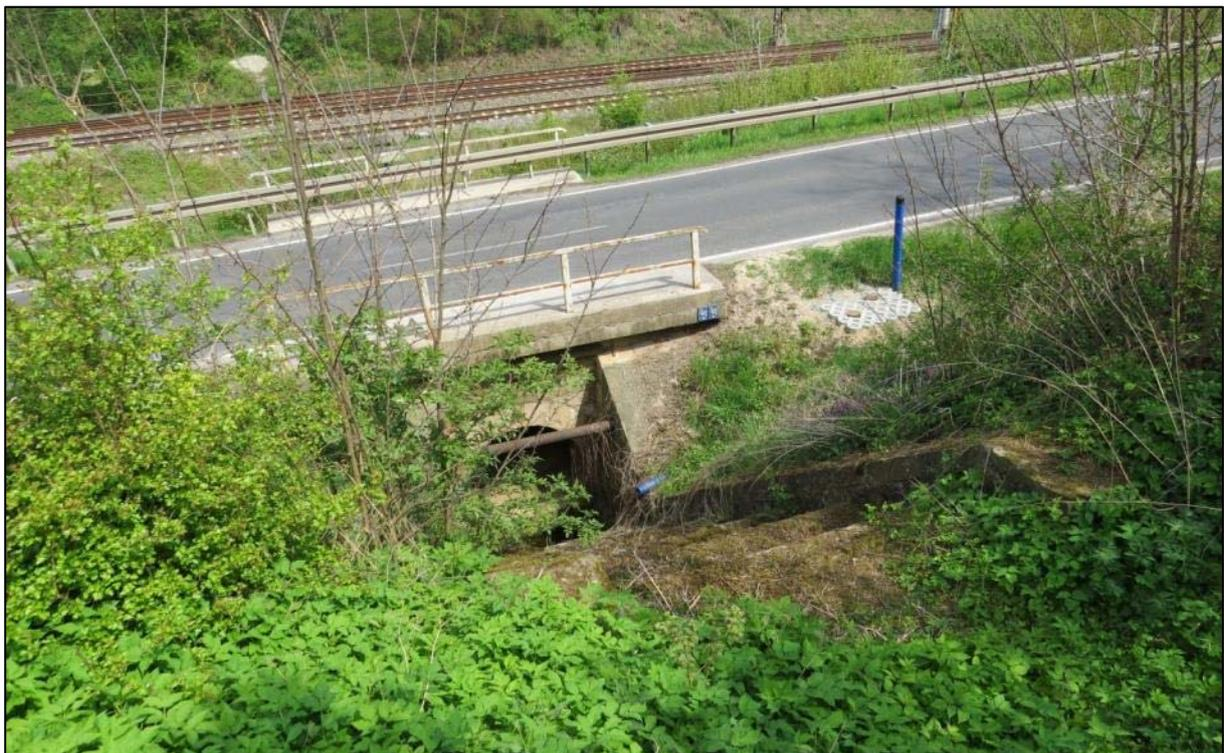
**Abb. 9: Faulgraben – Ausgebauter Durchlass unter der L 1061**
