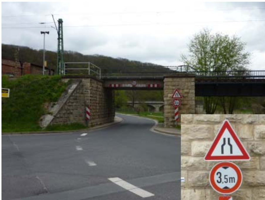
Abb. 9: Brückenbauwerk an Bahn-Strecke Großheringen – Jena, gelegen am Straßenknoten L 1061 und Abzweig Viegastraße
